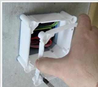
zusätzliche Aufstockelementen an Dämmdicke anpassen.
