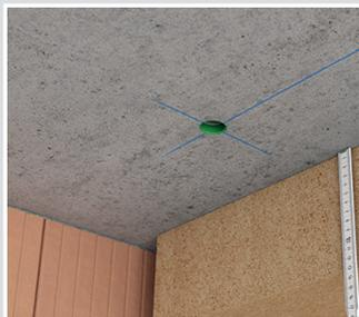
Épaisseurs d'isolation de 100 mm à 160 mm possibles (350 mm avec réhausse).
