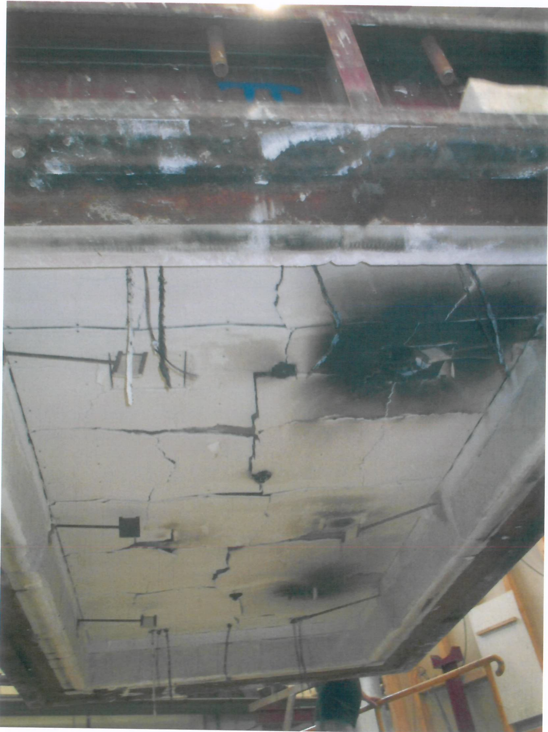
Probekörper nach dem Brandversuch von 35 Minuten Dauer Feuerseite
