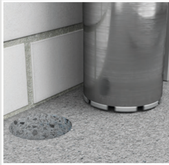
...oder passende Kernbohrung bei nachträglichem Einbau erstellen.
