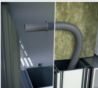
Schutzschlauch durch die Fassade führen
