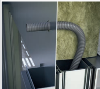
Faire passer la gaine de protection à travers la façade
